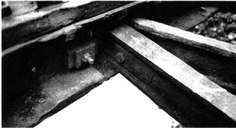
図5 橋桁と繫梁及び筋違の接合状況 3)
