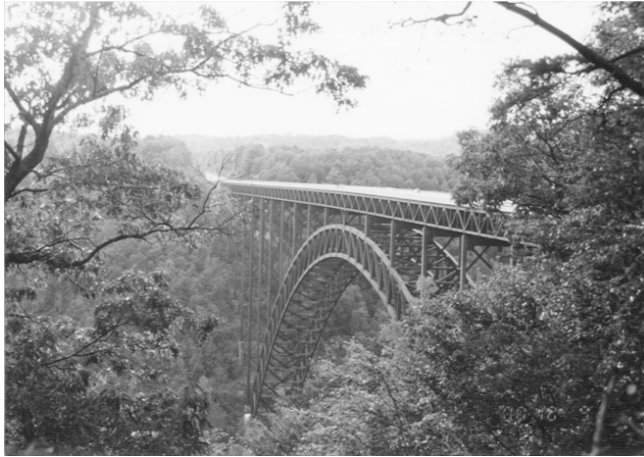
写真2 耐候性鋼を用いた大鉄橋 (ニューリバーゴージ橋、米国ウェストバージニア州)
