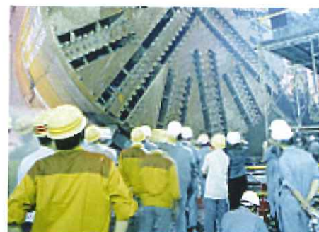
シールドマシンのUターン現場
