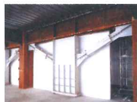
低降伏点鋼による制振ダンパーの例
