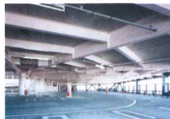
駐車場に耐火鋼を適用した例
