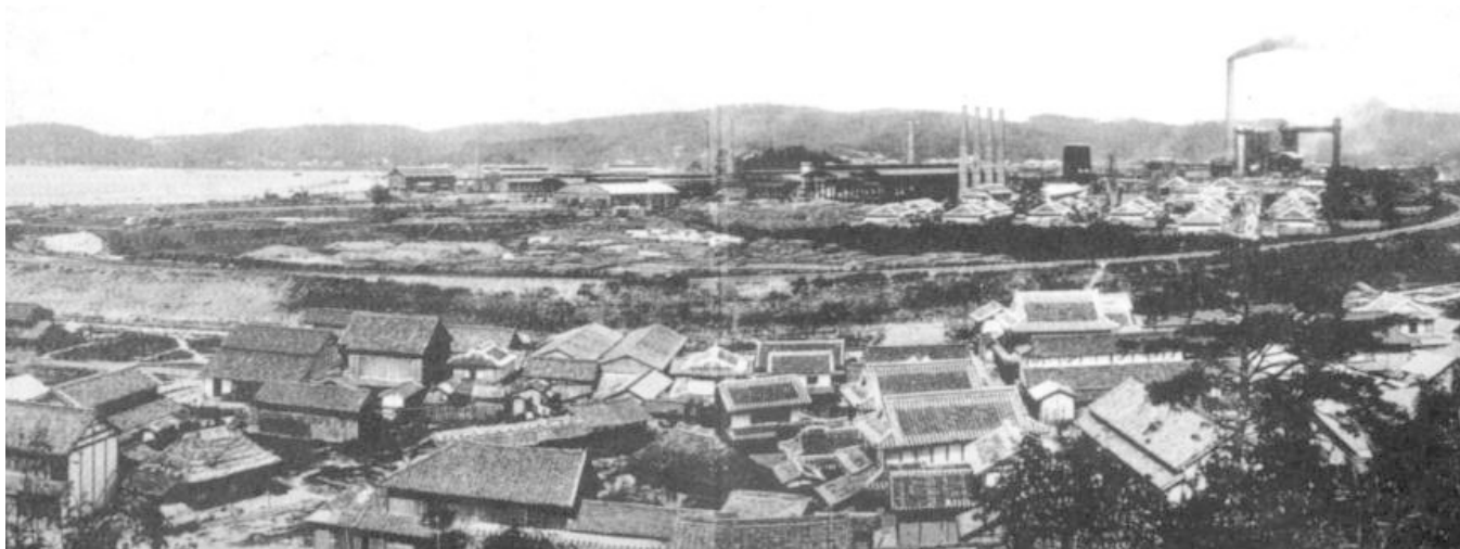
写真3 創業期の官営八幡製鉄所全景 9) 右側煙のところが東田第1高炉（ドイツ式、日産160t炉）。その向かい線路をへだて八幡停車場。 中ごろの煙突4本あたりに製鋼工場、そのやや左に圧延工場、左手に広がる海が洞海湾
