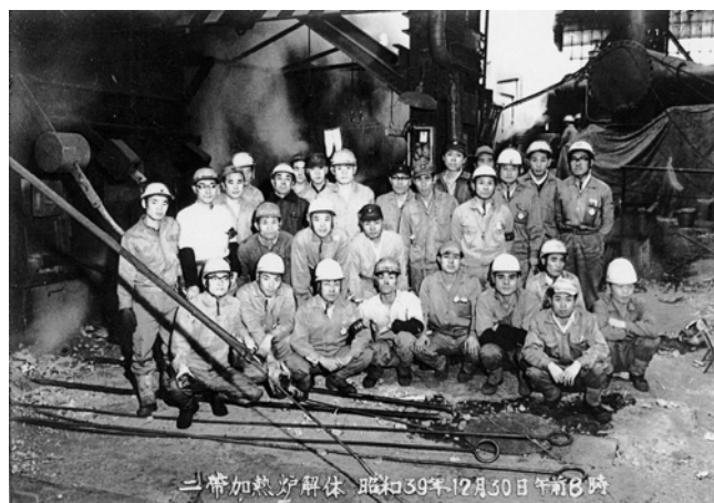
図2 傾斜炉床式加熱炉(最終操業)
