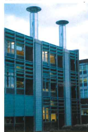
BRE (英国建築研究所) による、鉄を使った完全リサイクル建築の例 (提供:野城智也氏)
