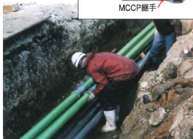
情報BOXで使われる保護管(MCCP鋼管)の構造(上)と敷設。MCCP鋼管は、Metal C.C.Box Pipe type 鋼管の略称である
