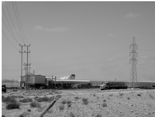
ヨルダンの製鋼・圧延工場
