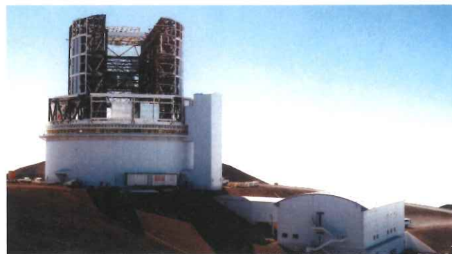
ドームの鉄骨構造(1995年1月)
