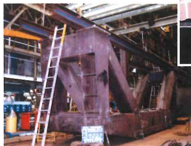
鏡筒構造を支えるセンターセクションは厚さ40mmの鋼板によるボックス構造
