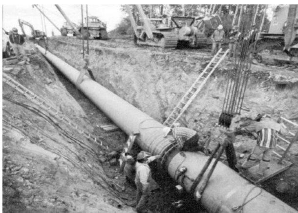
図 パイプライン建設工事
