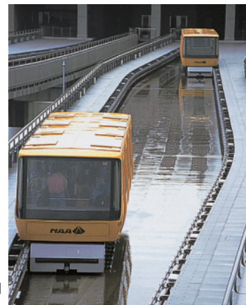
成田空港第2旅客ターミナルからサテライト間を結ぶ水平式エレベータ(シャトルシステム)。
