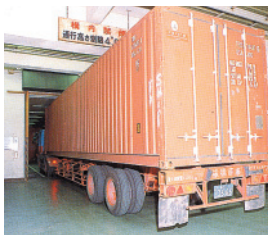
東京・品川の(株)寶組勝島倉庫に設置された大型トレーラ用エレベータ。かごは高さ4.4m、幅4.1m、奥行き19.2mで、世界最大積載量50tを誇る。
