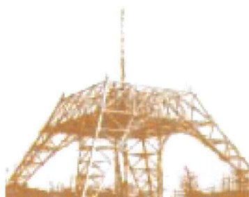
塔脚4面併合が完成。鉄骨を持ち上げる起重機シンボルが立ち上がった。
