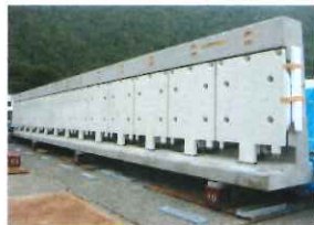
建設コスト低減のため、施工性の高いガイドウェイ側壁の開発が行われている(山梨実験線)
