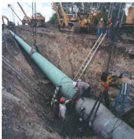
世界最高強度のX-100グレードのパイプライン建設工事(カナダ)。世界初の同グレード生産にはSuper-OLAC(NKKの厚鋼板加速冷却システム)が適用された。(資料提供:JFEスチール(株))
