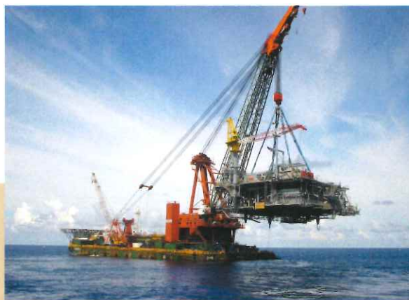
海上プラットフォーム (据付中)
