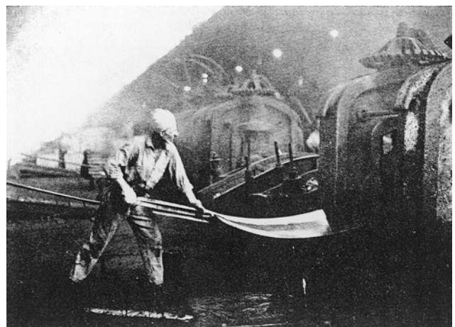
図3 1900年代初期における熱延珪素鋼板圧延作業 (Armco社)
