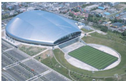
札幌ドームの屋根架構は、直交する格子状の鉄骨アーチにより構成され、独特なシェル型を形成している。
