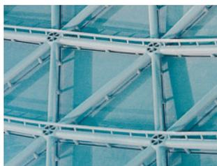
ナゴヤドームは三方向グリッド方式の単層ラチスドーム構造で、直径65cm、一辺約10mの鋼管が使用されている。6本の鋼管部材が集まる接合部(写真右)には鋳鋼製ノードが使用されている。
