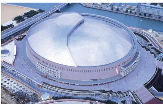
福岡ドームの屋根の開閉は、2枚の屋根パネルが球場外周部を走るレールをガイドに、それぞれ24台の走行台車に支えられながら、左右に最大120度旋回移動して行われる。
