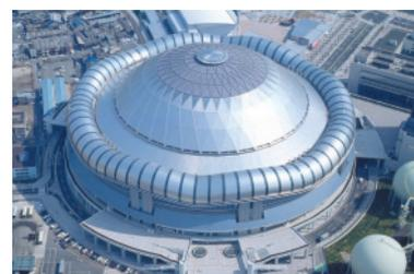
大阪ドームの本体部の屋根は、トラスをラメラ状(木の葉の編み目のような形状)に組み合わせた鉄骨造ラメラトラス構造となっている。
