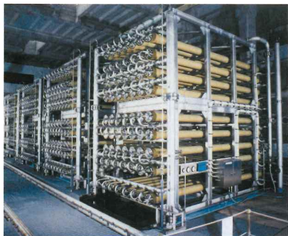
1997年沖縄県北谷町に建設された国内最大の逆浸透膜設備
