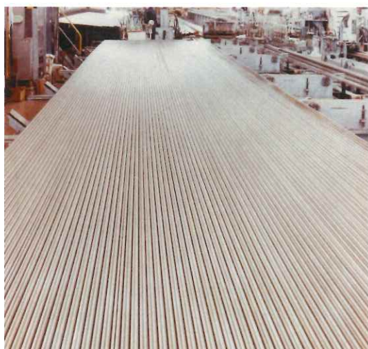
アルジュバル海水淡水化プラントには、約5万本のチタン製伝熱管が使用され、20年間の操業において腐食が皆無であったことが報告されている
