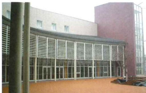
鉄骨を生かした回廊によりスケール感のある空間が生まれた(早稲田実業学校、設計：新日本製鐵(株))
