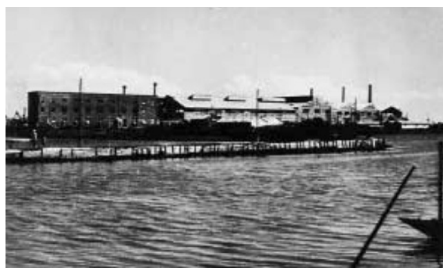
図6 西側から見た日本特殊鋼 羽田工場 13)
