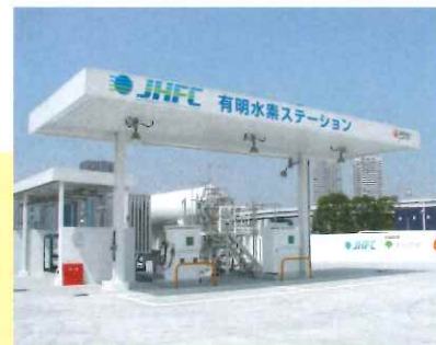
日本初の液体水素ステーションである 有明水素ステーション
