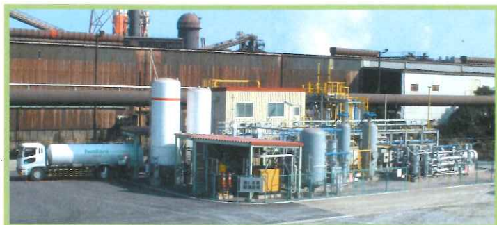
コークス炉の副生水素ガスから液体水素を製造する世界初の実証設備 (新日本製鐵(株)君津製鐵所内)
