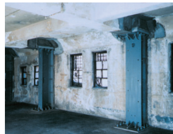
鉄骨バットレスによる外壁補強部分。
