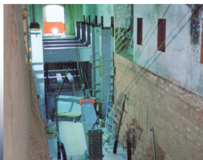
階段室耐震コア化の作業は、人力で鉄骨を運んで進められた。この時、殆どの階段室はコア化したが1号倉庫西側の端の階段とスロープは現在も保存しており、見ることができる。
