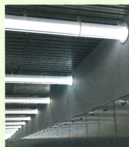
コンピュータ室天井の照明設備
