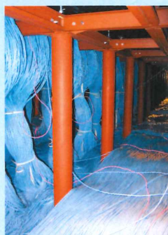
コンピュータ室の床下に納められた大量のケーブル
