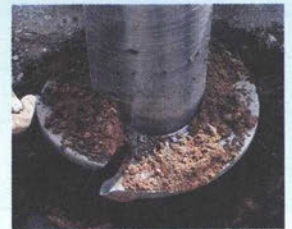
逆回転により撤去できる回転貫入鋼管杭
