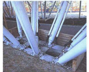
幾本もの鋼管が扇状に回廊を支える鉄扇構造。支点が集約され基礎が低減されている
