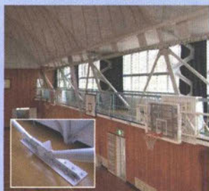
ブレース設置状況
