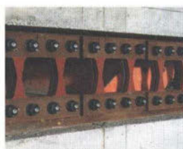
せん断型の鋼材ダンパー (写真提供:鹿島建設(株))
