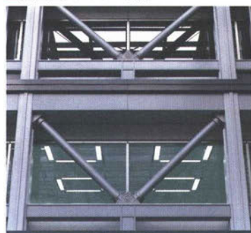
アンボンドブレース(写真提供:新日本製鐵(株))
