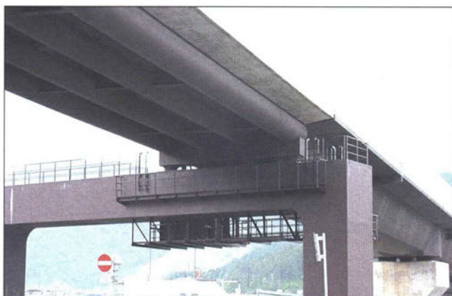
北陸新幹線北陸道架道橋（新潟県、1999年竣工）は、ニッケル系高耐候性鋼の初めての適用例である。
