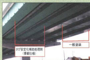
景観仕様のさび安定化補助処理剤を適用した効安質高架橋(写真提供:川田工業(株))
