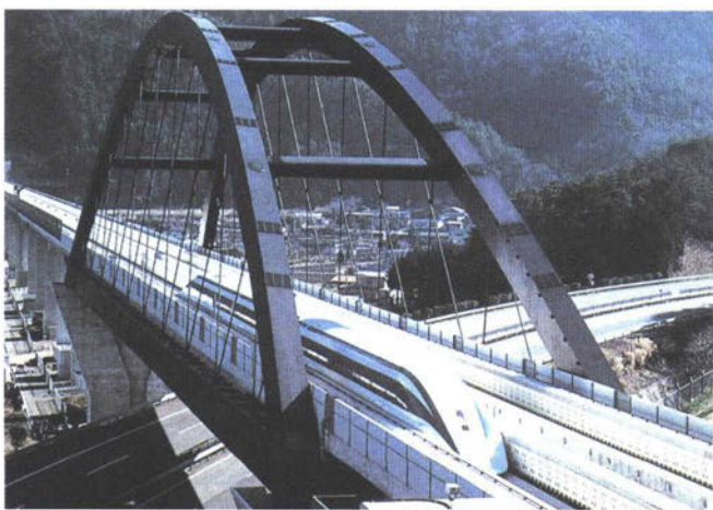
山梨リニア実験線に建設された小形山架道橋（山梨県、1996年竣工）
