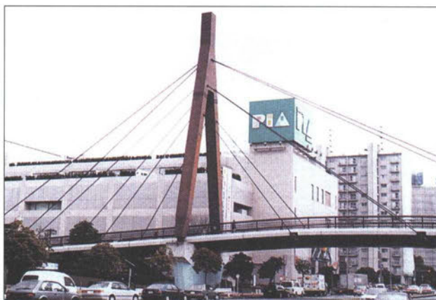
ふれあい橋（千葉県、1987年竣工）は都市景観と調和するデザインの斜張橋
