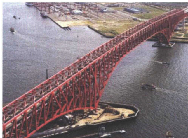
大型のHT使用橋である南港大橋
