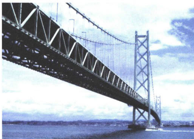
本州四国連絡橋を契機に重防食塗装の採用が本格化した(写真は明石海峡大橋)
