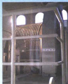
大規模な開閉装置。高強度なワイヤロープにより扉が開閉される
