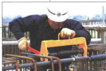
機械式継手の例（カプラーとナットで接合し、グラウト材を注入することにより固定する方式）
