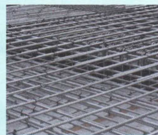
ステンレス鉄筋の例 (写真提供: (株)三和、ステンレス鉄筋製造: 愛知製鋼(株))
