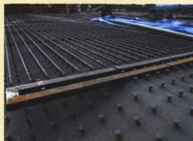
最近では杭の間隔を狭めることで、季節間蓄熱を実現している。写真は鋼床版橋と呼ばれる橋の放熱管設置の状況。この場所の地下では橋梁基礎杭の利用が難しかったため、熱交換専用杭を密に配置している
