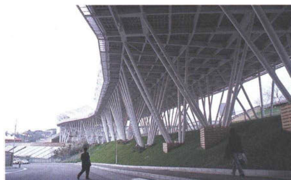
回転杭工法が全面的に採用された愛知万博のペDESTリアンデッキ。会期終了後、施工時と逆回転して引き抜いたところ、工事後も周囲への影響が少なく、同時に杭の健全性が確認された。
