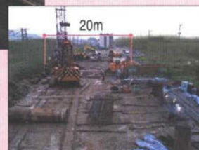
場所打ち杭では、回転杭に比べ広い施工スペースを必要とする。
