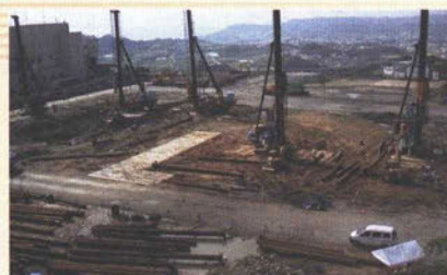
那覇市環境センターでの施工状況
