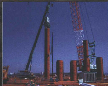
建設が進む東京港臨海大橋（仮称）工事では、高度な鋼管矢板基礎技術が適用されている。（2006年12月撮影、写真提供：国土交通省関東地方整備局東京港湾事務所）
