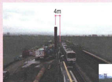
回転杭(左)と場所打ち杭(下)の施工スペースの比較。既存の軌道に近接した狭いスペースでも回転杭は施工が可能である。
