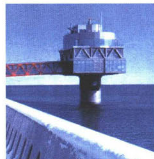
紋別港の水展展望塔ではチタンクロード鋼のライニングを干満部に適用している。([「海洋鋼構造物へ適用される防食工法に関する研究」資料より])
