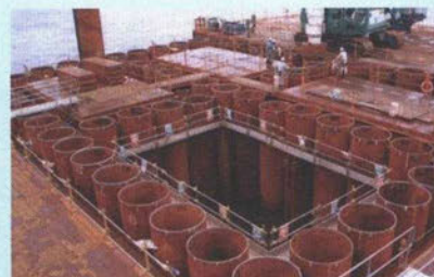
杭基礎工事の状況
