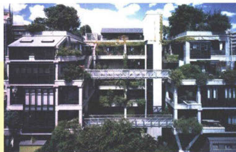
実験集合住宅「NEXT21」では、2007年4月から第3フェーズ居住実験を開始する予定で、700W級家庭用SOFCコージェネレーションシステムの実証試験も行われる。写真提供:大阪ガス(株)
