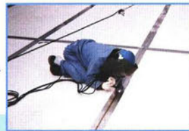
接合部はすべて溶接し、溶接後は電解研磨処理などを施す
