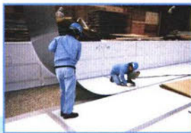
現地に搬入された大型パーツを組み立てる
