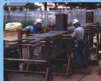
鉄骨梁と柱鉄筋の仮組作業
