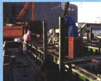
コンクリート打設
