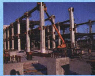
鉄骨梁の組立
