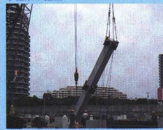
プレキャストRC柱の建て込み作業
