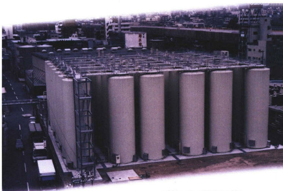
日本酒メーカーで用いられる生酒貯蔵用タンク。大規模な生産に用いられる屋外用、200klの大型のもので、この写真では48基が並んでいる（白鶴酒造(株)）。
