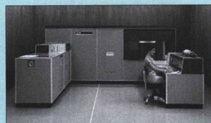
1956年に誕生した世界初のハードディスク「RAMAC」は、24インチディスク50枚で構成されていたが、それでも記録容量は5MBしかなく、記録密度は2Kbit/in 2 だった。(Reprint Courtesy of International Business Machines Corporation, copyright &copy; 1956 International Business Machines Corporation.)
