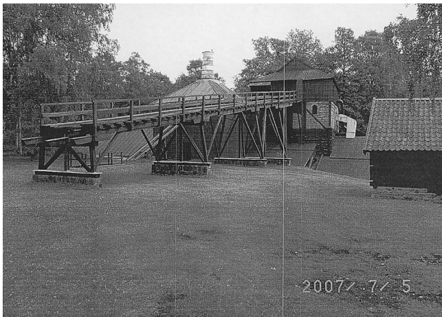
写真1 キルンと溶鋳炉を内蔵する木造建屋
