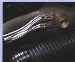
アース端子の取り付け状態
