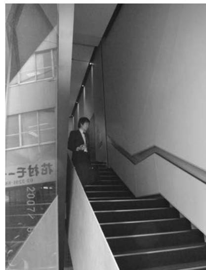
写真4 2階への階段と鋼板製側桁
