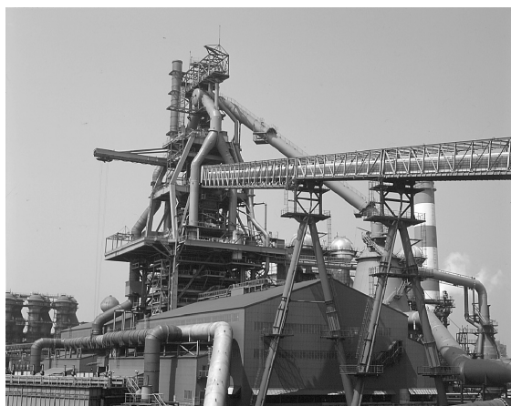
図 加古川2高炉外観
