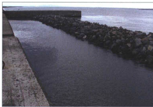
砂礫浜による波高の低減。砂礫を活用して衝撃を吸収することができ、崩れた場合も復旧がしやすいメリットがある。(資料提供:(独)港湾空港技術研究所)
