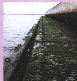
消波ブロック(左)、被覆ブロック(右)への適用。施工後、被覆ブロックには多様な海藻が着生し、生物付着性が確認された。
