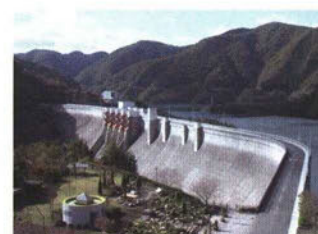
ダム(写真提供:中国地方整備局弥栄ダム管理事務所)
