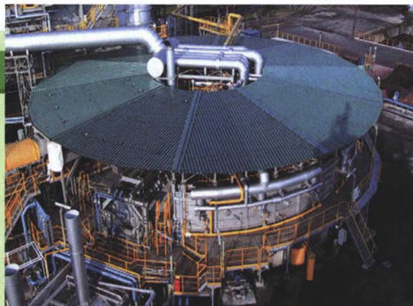
回転炉床炉を利用した再資源化により、2006年度ダストリサイクル率96%、スラッジリサイクル率64%を達成したところもある。
