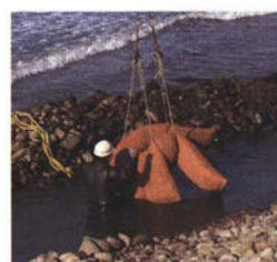
鉄鋼スラグユニットを埋設したところ、埋設部から沖合30mほどの海域にコンブが生育し、2、3年後もその効果が継続することが確認された(資料提供:新日本製鐵(株))
