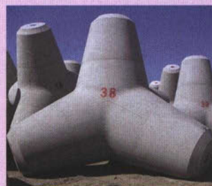
消波ブロック(左)、被覆ブロック(右)への適用。施工後、被覆ブロックには多様な海藻が着生し、生物付着性が確認された。
