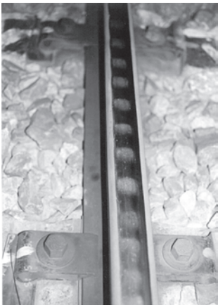
図17 曲線内軌波状摩耗
