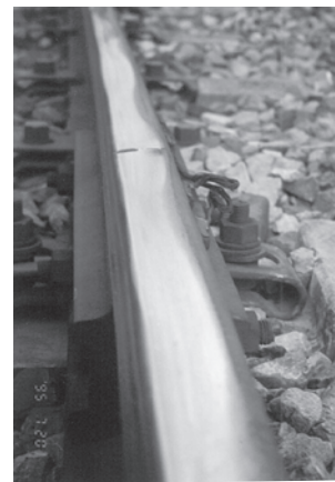
図 19 曲線外軌波状摩耗
