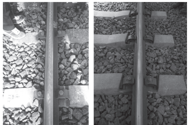
図 20 直線波状摩耗（左：短波長、右：長波長）
