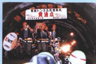
先進導坑の貫通(昭和58年1月27日)貫通点の誤差は距離19mm、高低196mm、左右644mmと極めて小さく、世界を驚かせた。これは地球の曲率をも考慮した高度な測量技術が導入されたことによる。
