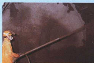
NATM工法の先駆けとなった吹付コンクリート。ただし青函トンネルでは土圧は支保工で支えたため、地山の保持力を利用するというNATMの概念は生かされていない。
