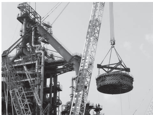
図 神戸 3 高炉改修時のブロック工法
