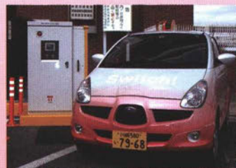
首都高速湾岸線の大黒パーキングエリアに設置された急速充電器(写真左)と富士重工業の電気自動車(写真右)。(写真提供:東京電力(株))
