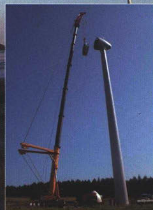
国内最大クラスの出力を誇る福島・郡山布引高原風力発電所。(右) 発電機などが収納されたナセルの取り付け。(写真提供:電源開発(株))
