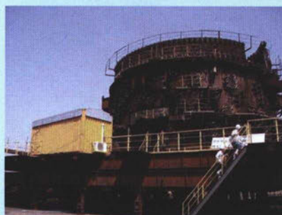
旧大分第2高炉の解体
