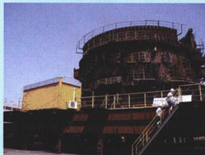
旧大分第2高炉の解体
