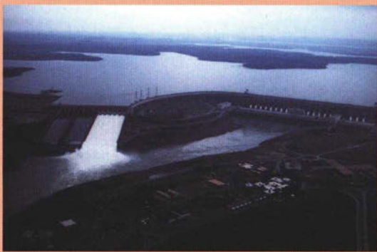
巨大なイタイプダム(資料提供: (財)日本ダム協会)
