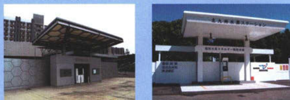
九州大学 水素ステーション
